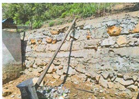
Foto 9: Muro de contención o perimetral. 3 y 22 mts.
