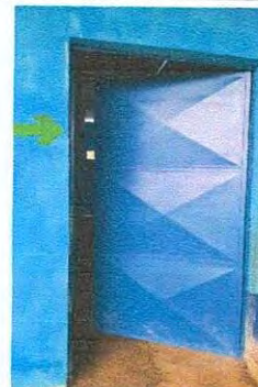
Foto 6: Colocación de puerta (b)
