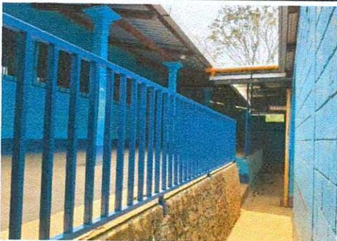
Foto 5: Levantamiento de muro de seguridad metálico.
