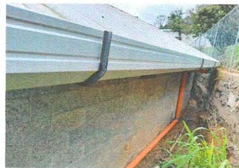
10. Colocación de canaleta y bajadas en cocina.
