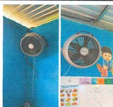
Foto 6: Colocación de 2 ventiladores, aula 1 y 2.
