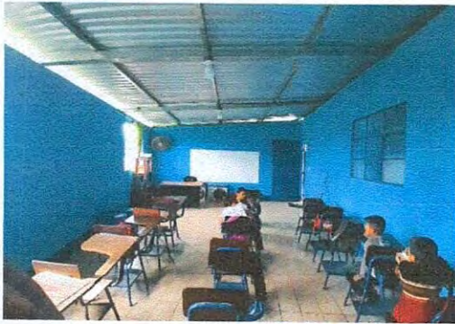
Foto1: Colocación de Techo
