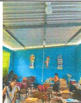
Foto 2: Colocación de sistema eléctrico aula 2.
