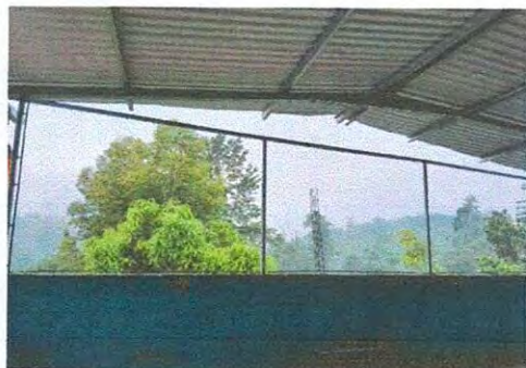
Foto 9: Colocación de malla metálica. Fase 2. salón.
