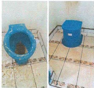
Foto 7: Colocación de 2 letrinas.
