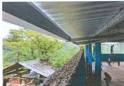
Foto 8: Colocación de canaleta del salón
