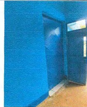
Foto 2: Colocación de puerta (a)
