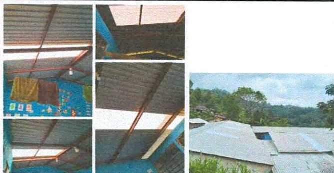
Foto1: Colocación de lámina troquelada lamiluz. 4 aulas.
