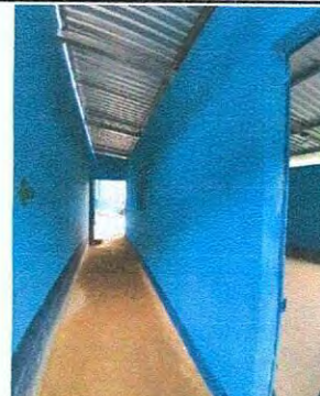
Foto 4: Levantamiento de pared de division y cernillado.
